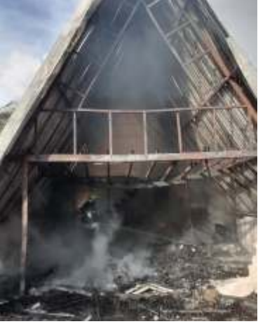
Fethiye'nin Karaağaç Mahallesi Kirme mevkiinde
